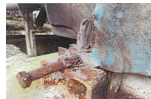
Baseplate มีสนิมและกัดกร่อน
